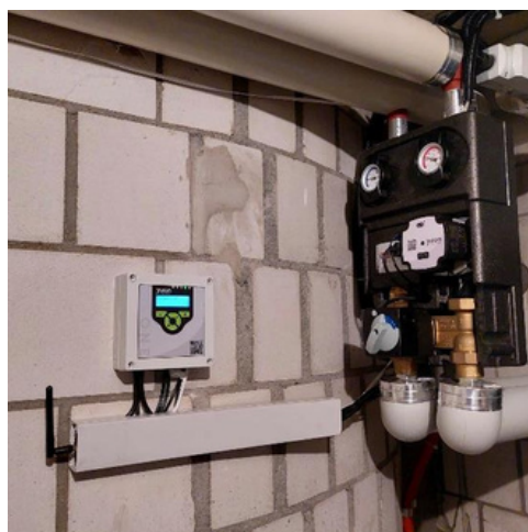
Yuon ONE mit Luft-Wasser-Wärmepumpe und Fussbodenheizung
